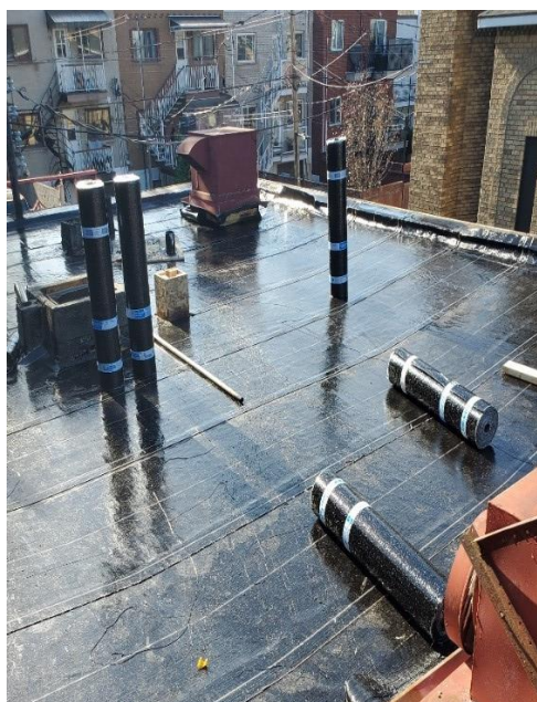
Imagine de la acoperișul Casei Române
